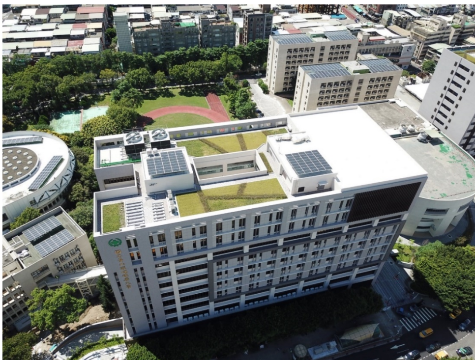
圖 4 第二期建置太陽光電發電設備(3 棟學生宿舍)
