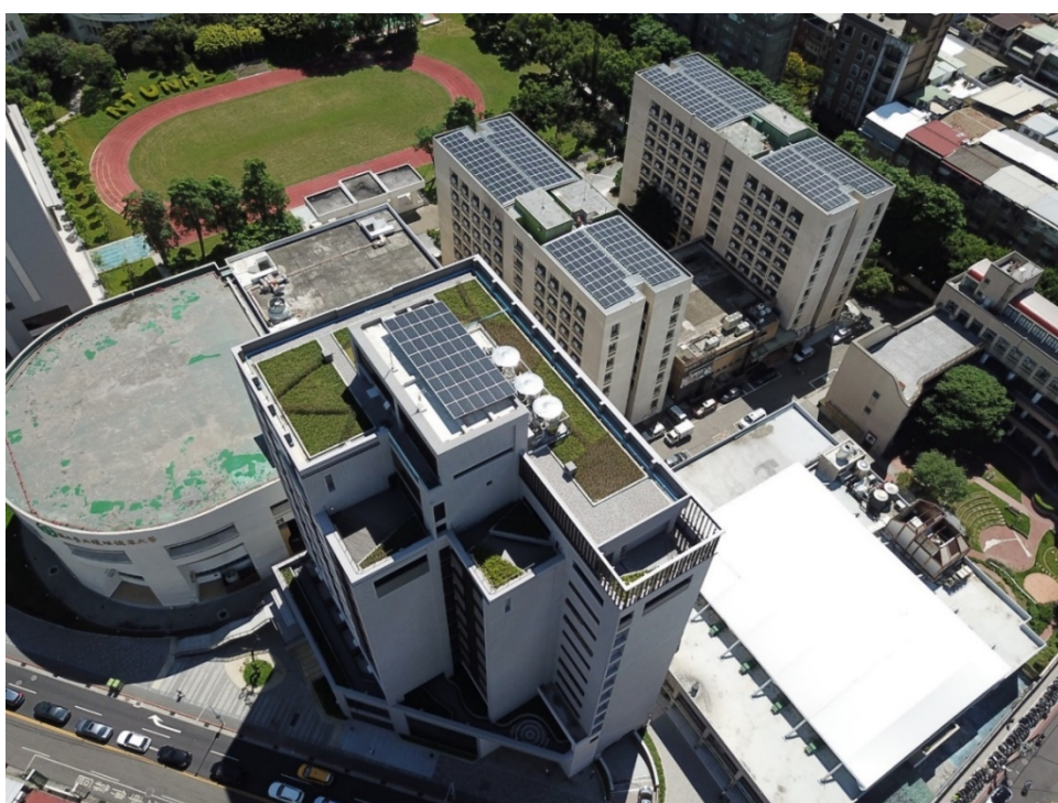
圖 4 第二期建置太陽光電發電設備(3 棟學生宿舍)
